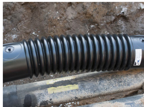
SXB-WP auf der Baustelle
